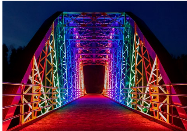
Puente de los Remedios, Villafranca de Córdoba 2022
